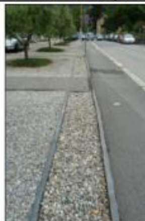
Puits et tranchées d'infiltration
