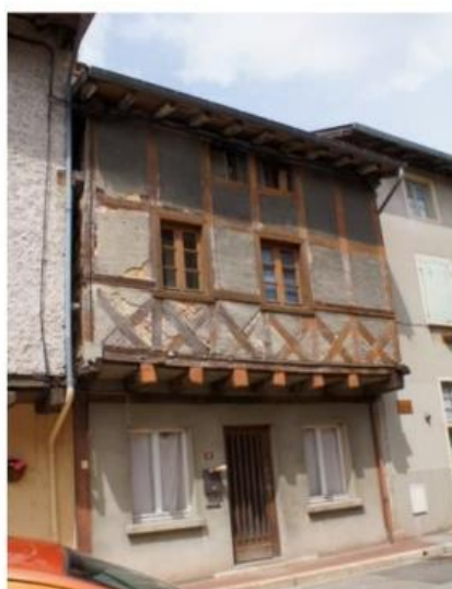
Maison Bolli - monument historique inscrit partiellement (façade) le 22/02/1927 (rue des halles)
